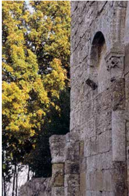
● Dettaglio della facciata della Badia
