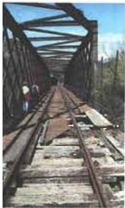
• Un viadotto della ferrovia Sicignano - Lagonegro presso Polla.
